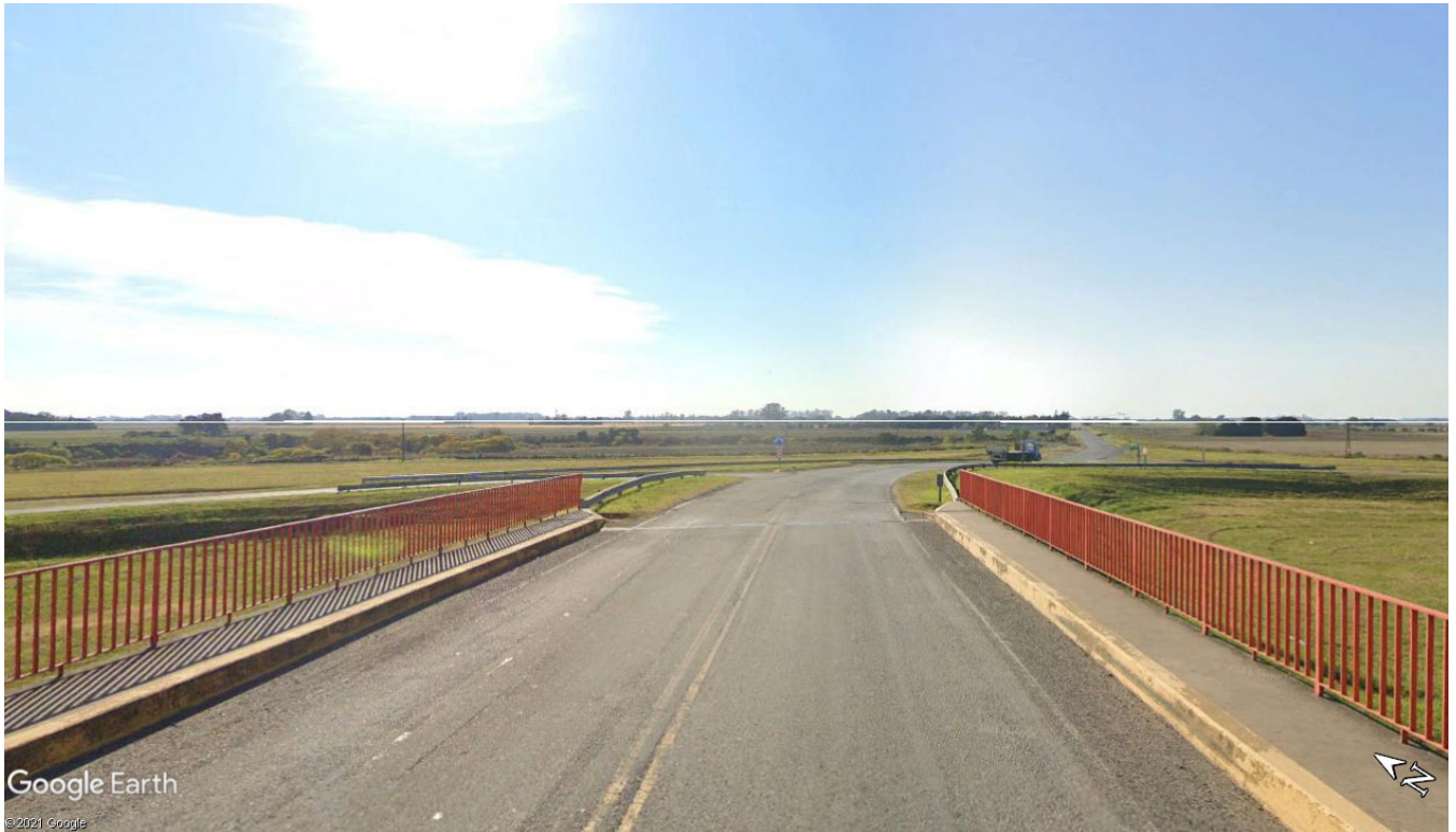
Imagen 10.15 – Vista de lado noreste sobre el puente de la intersección
