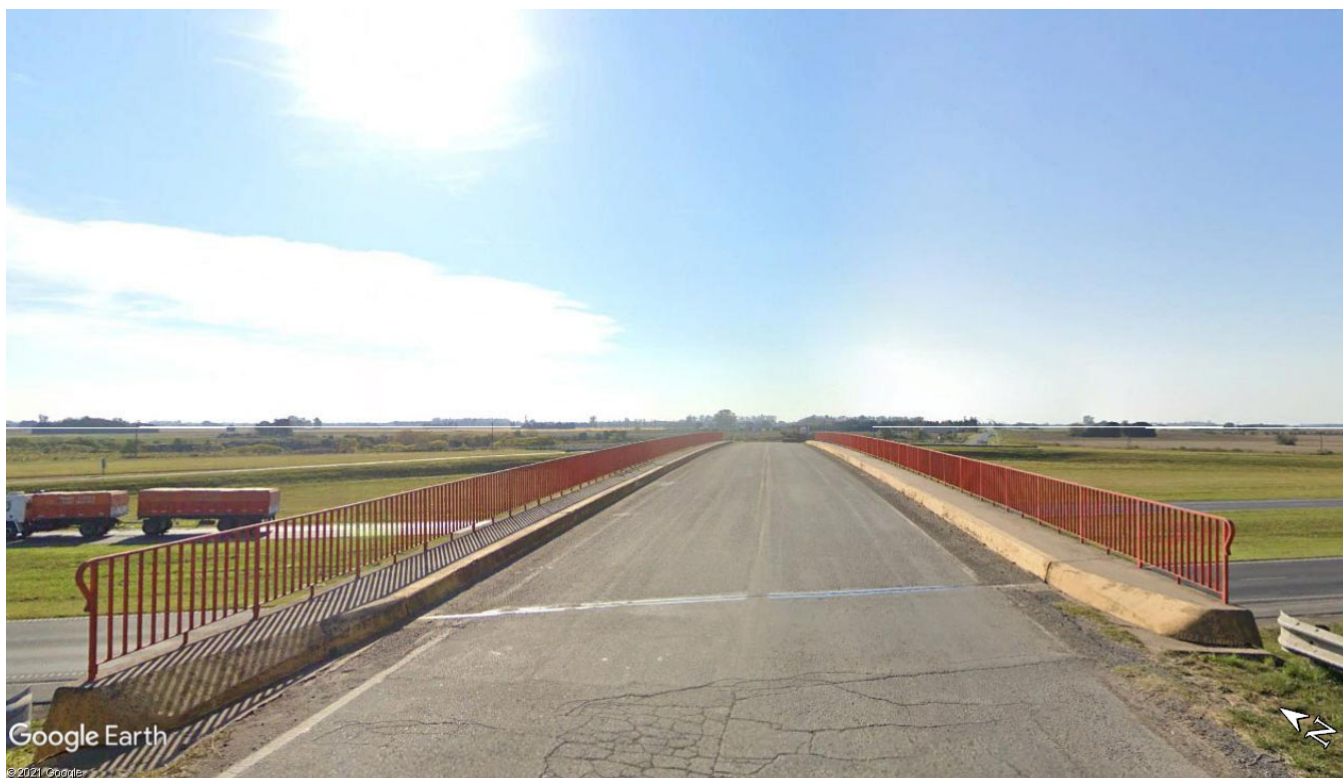
Imagen 10.14 – Vista de lado suroeste sobre el puente de la intersección
