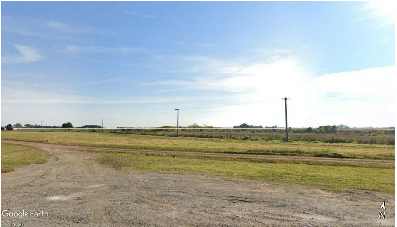
Imagen 10.5 – Vista de lugar de emplazamiento de SET y Pilar de Medición ubicados al Noreste de la intersección
