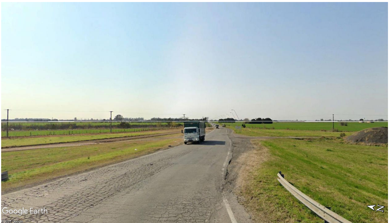
Imagen 10.4 – Vista de acceso a Gral. Lagos desde Rama de salida Asc
