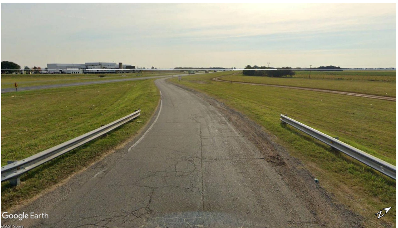
Imagen 10.6 – Vista de inicio de rama de entrada Asc. (ubicación de cruce subterráneo)
