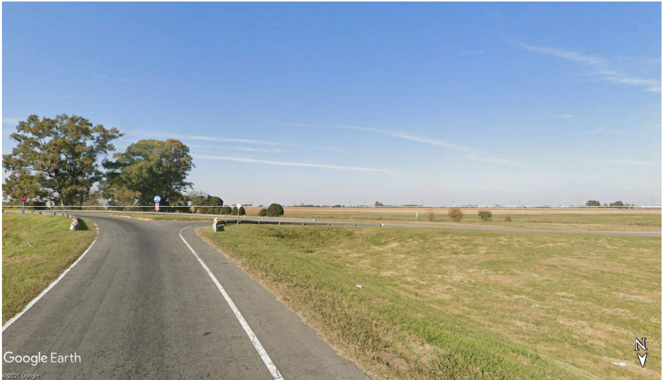
Imagen 10.11 – Vista de Rama de salida Desc. (ubicación de cruce subterráneo y Pilar de Toma y Medición)
