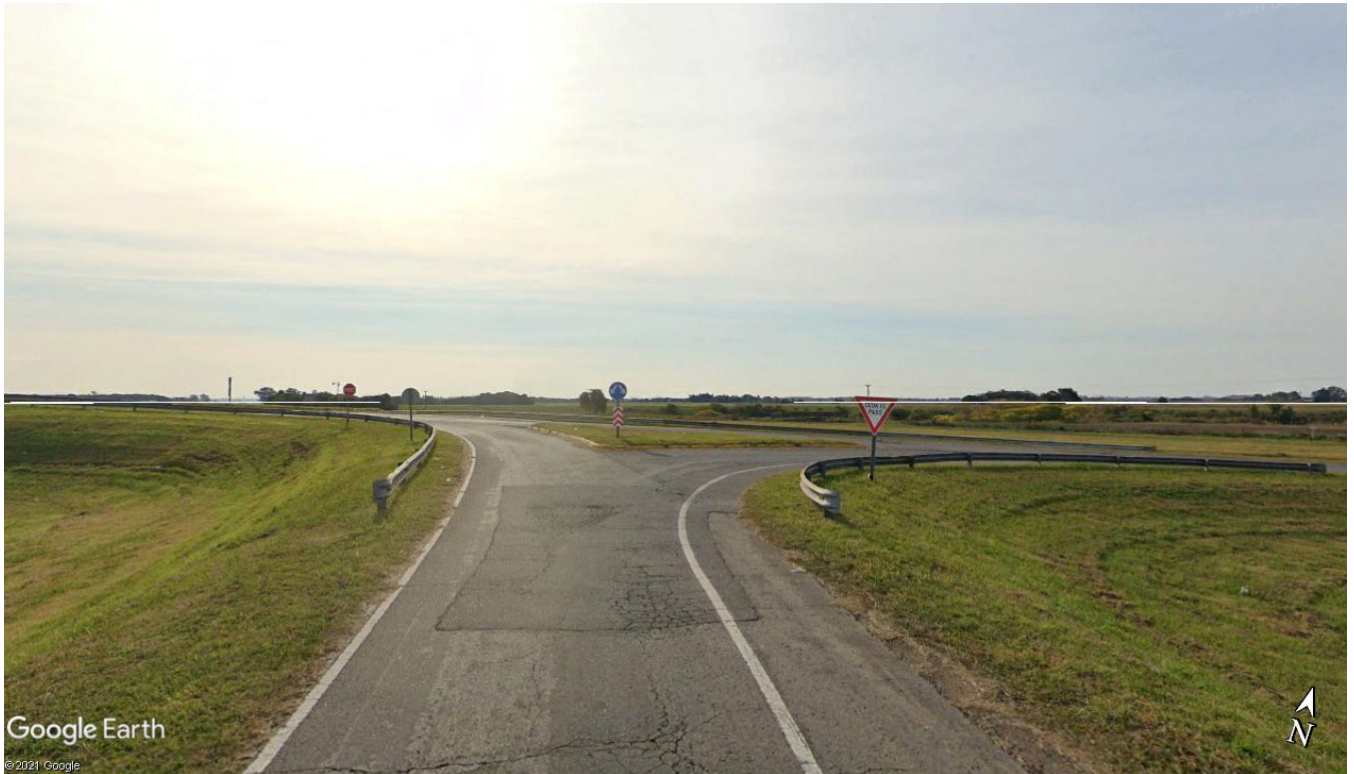
Imagen 10.3 – Vista de fin de Rama de salida Asc. (ubicación de cruce subterráneo)
