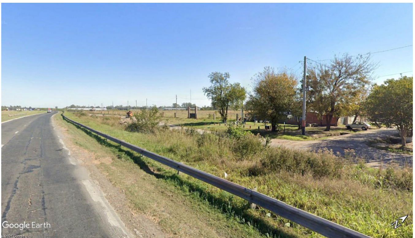
Imagen 10.3 – Vista de fin de emplazamiento de Rama de salida Asc desde RNN°9
