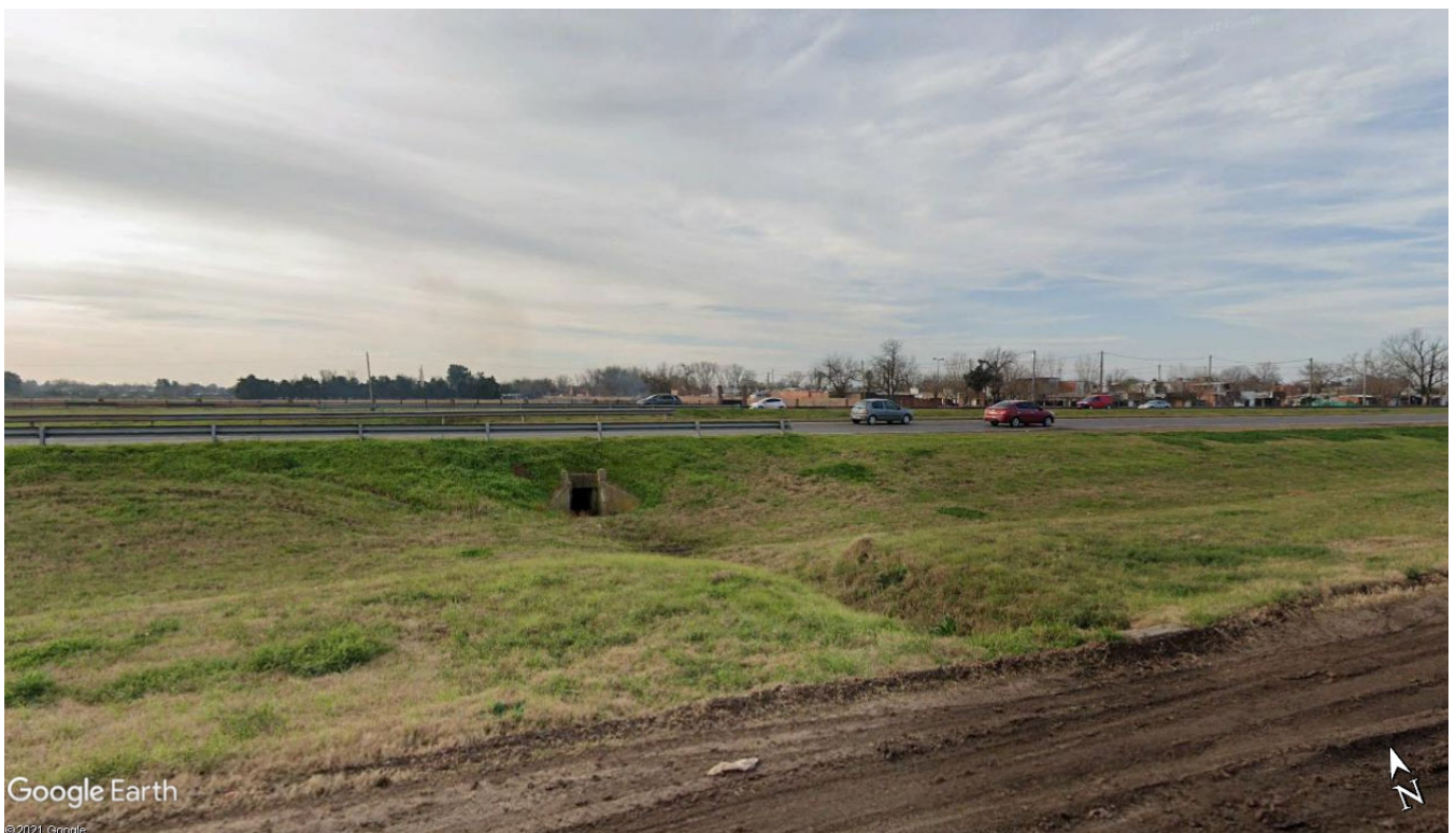
Imagen 10.7 – Vista de Alcantarilla a prolongar en rama de entrada sentido Desc.
