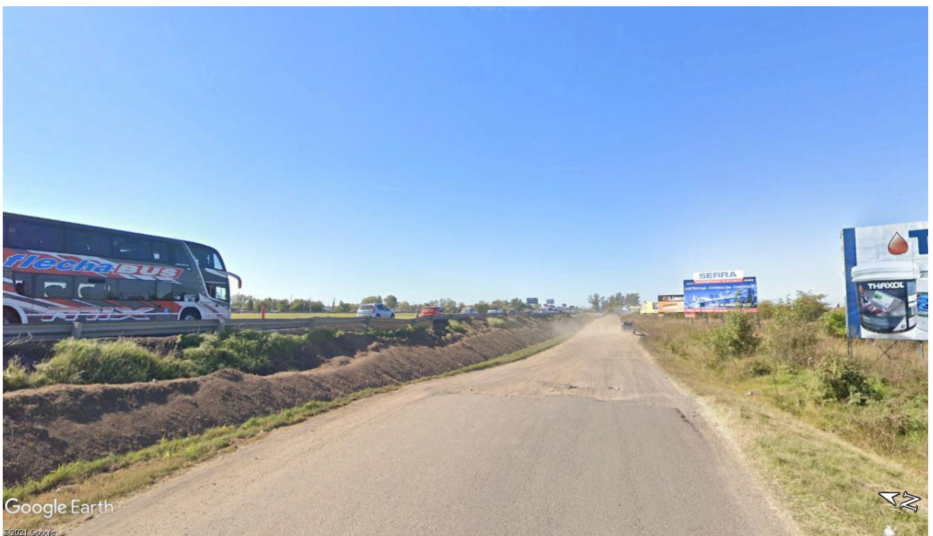
Imagen 10.5 – Vista de sector de ampliación de colectora Sur
