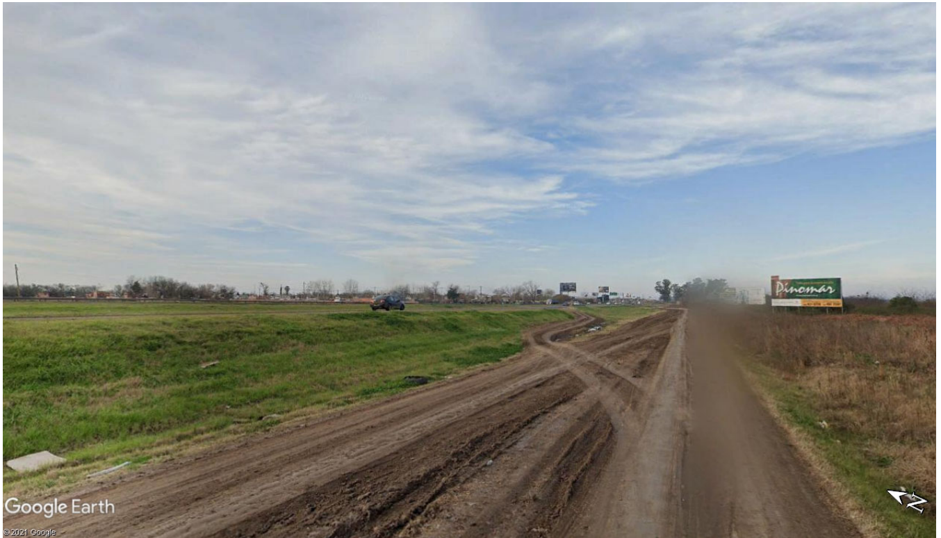
Imagen 10.6 – Vista de sector de Alcantarilla e inicio de rama de entrada Asc a ejecutar
