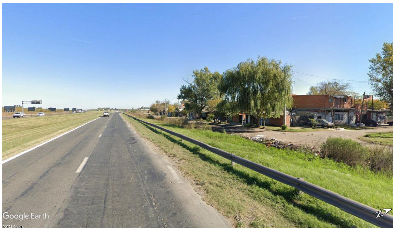
Imagen 10.1 – Vista de inicio de emplazamiento de Rama de salida Asc desde RNN°9
