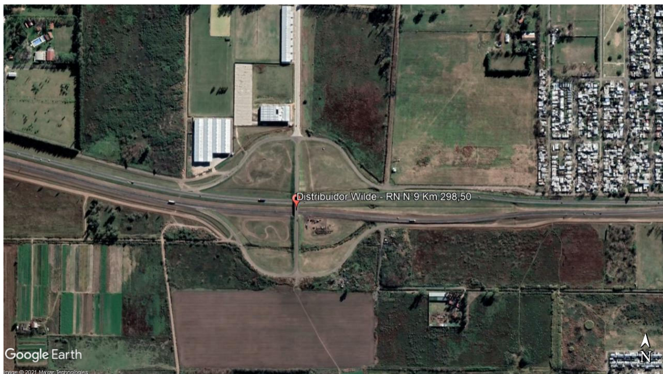
Imagen 2.4 – Imagen Aérea del distribuidor RN N°0009 Km 298,50
