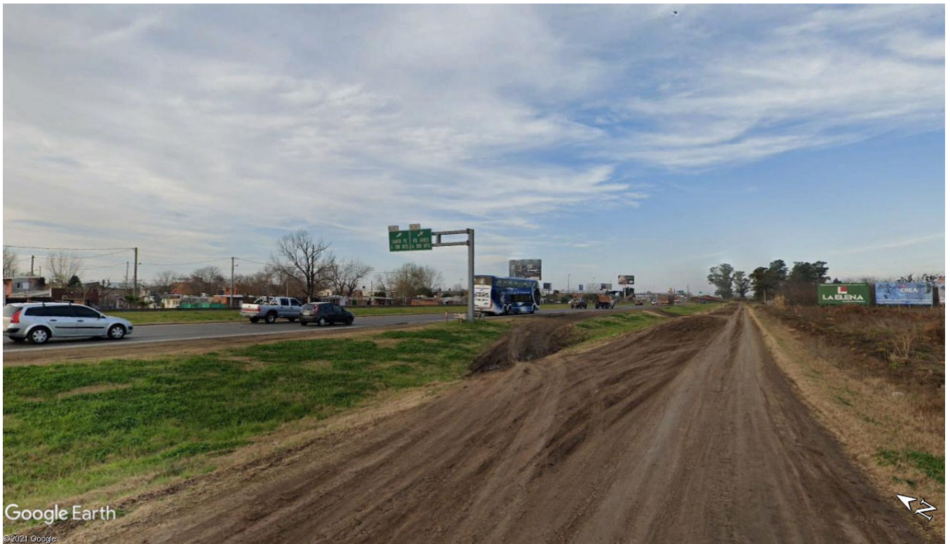
Imagen 10.8 – Vista de ménsula de señalización aérea a reubicar
