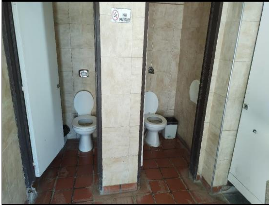
Fotografía 12: Baño de Acceso Público – Mujeres
