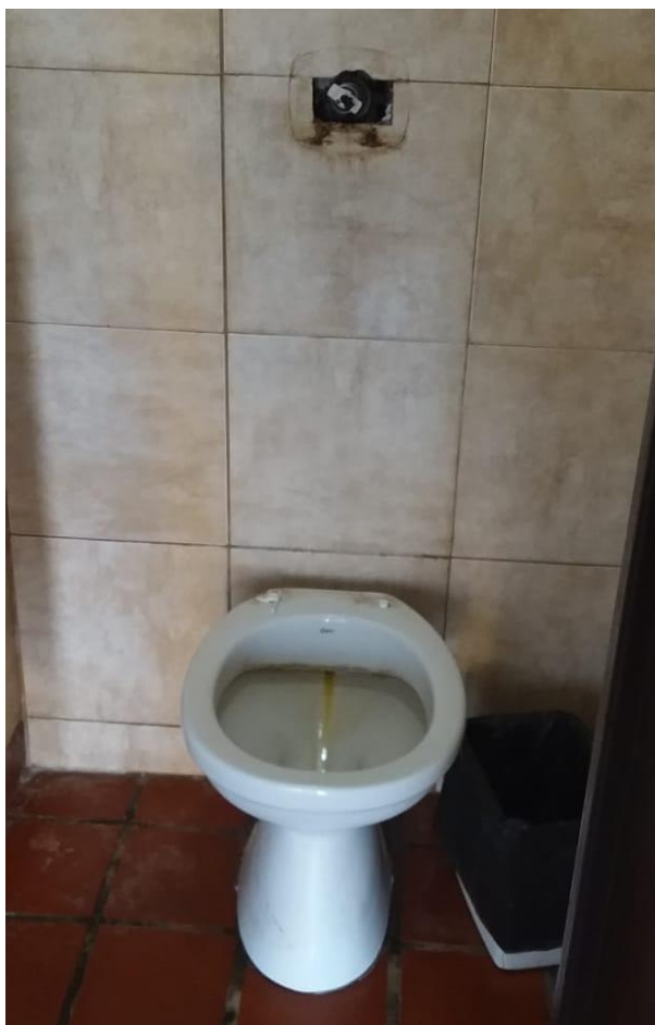
Fotografía 5: Baño de Acceso Público – Hombres
