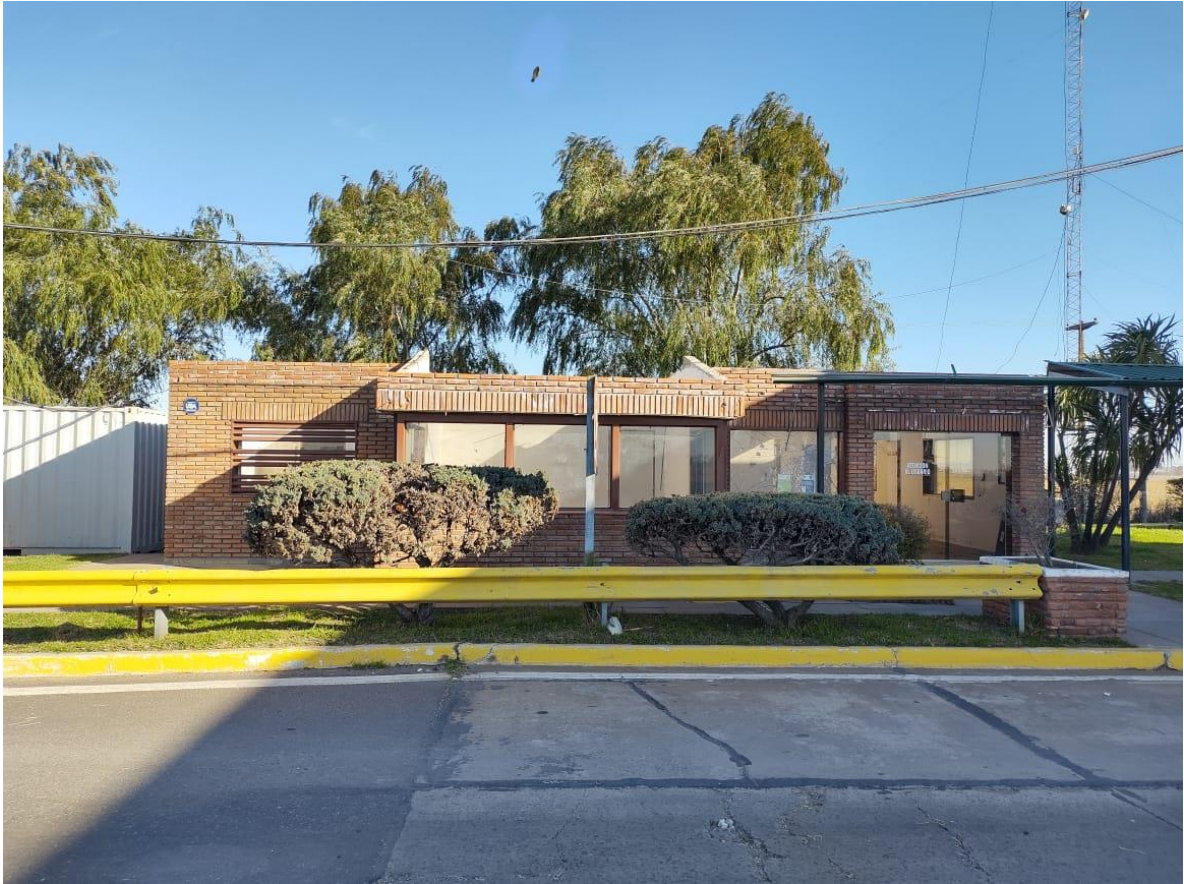
Fotografía 10: Vista general de las Oficinas del edificio administrativo.
