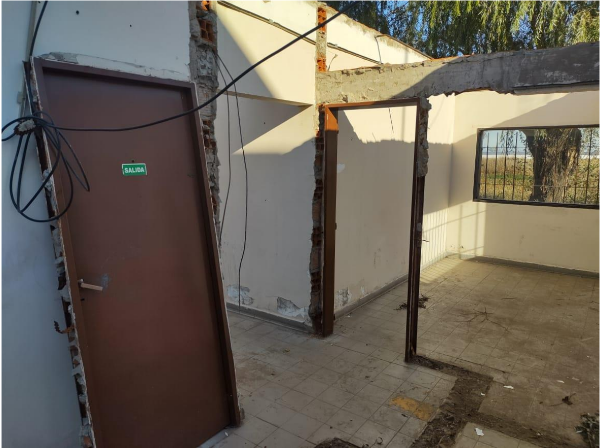
Fotografía 8: Paso distribuidor (Ambiente 03)
