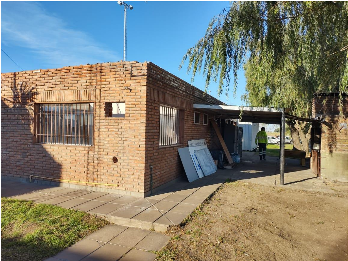
Fotografía 4: Exterior de oficinas administrativas
