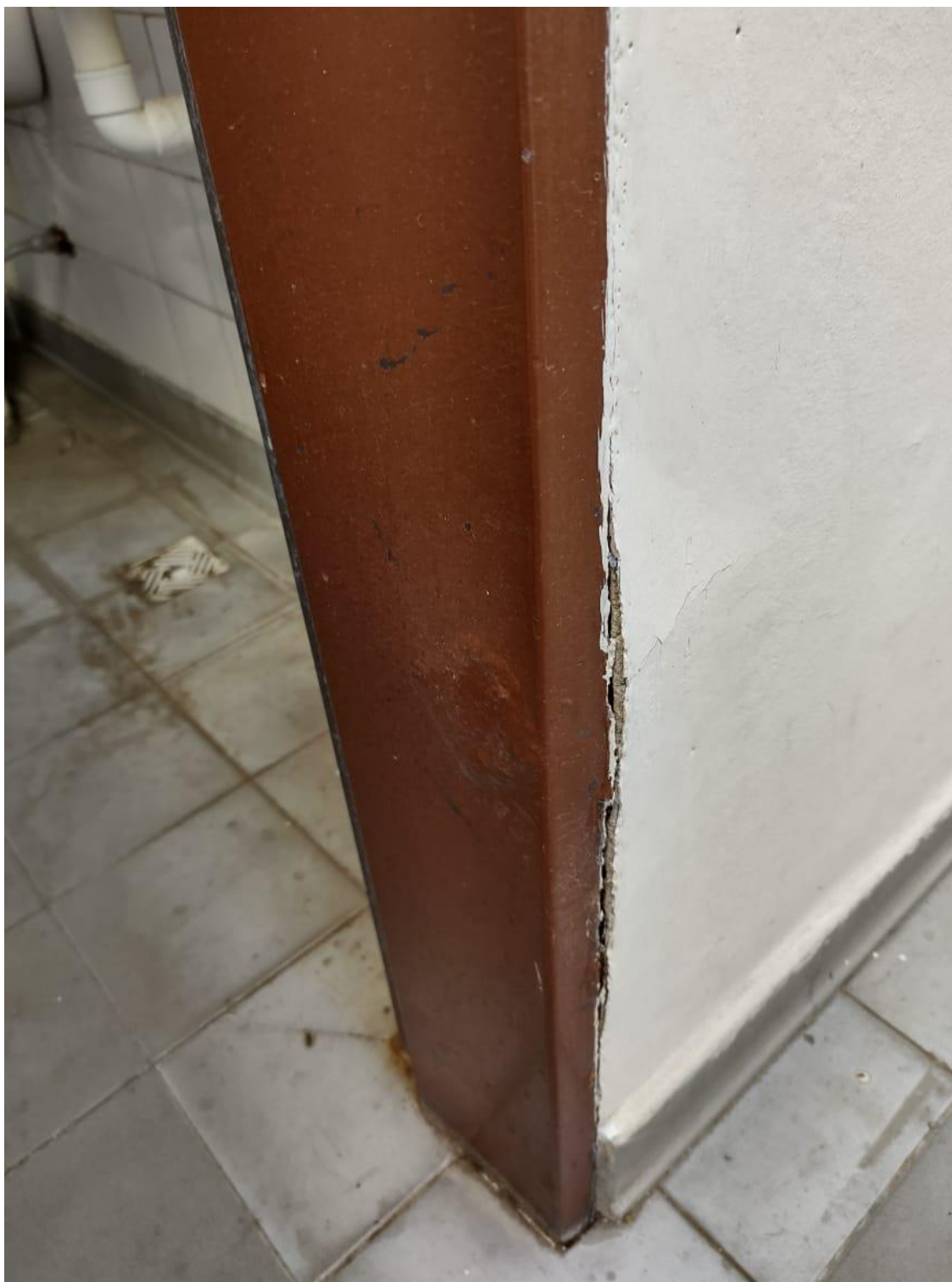
Fotografía 5: Marcos existentes de aberturas internas
