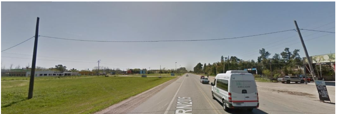
Imagen 11: Cruce de Línea de Baja Tensión sobre RN N°205
