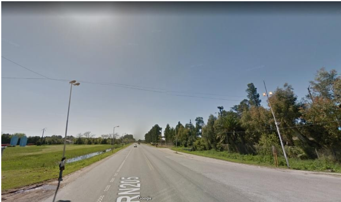
Imagen 9: Cruce de Línea de Baja Tensión sobre RN N°205
