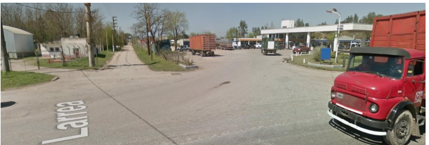
Imagen 19: Acceso Lateral con Alcantarillado - Margen Descendente (Estación de Servicio YPF)
