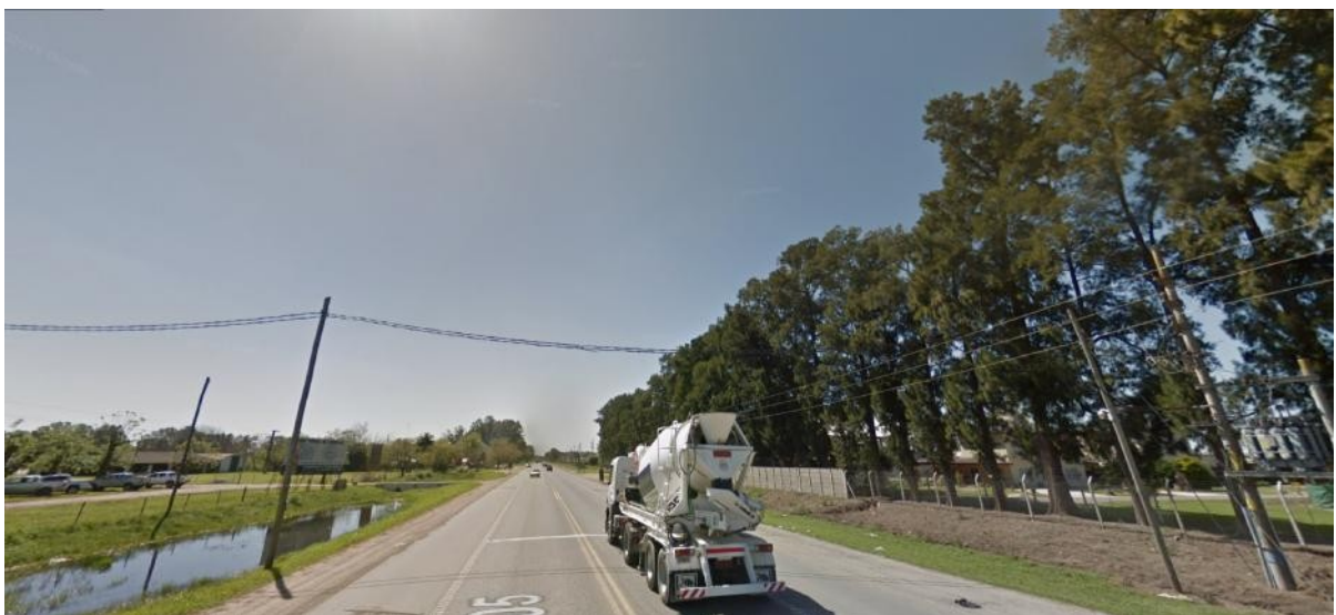
Imagen 10: Cruce de Línea de Baja Tensión sobre RN N°205
