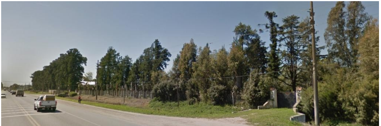
Imagen 6: Línea Eléctrica de Media Tensión - Margen SO
