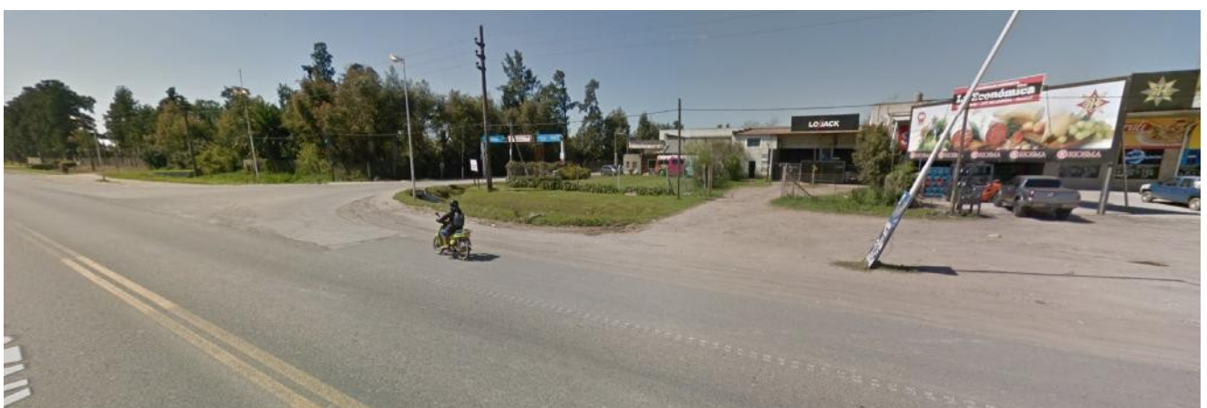
Imagen 8: Línea Eléctrica de Baja Tensión, tendida sobre Postes de Hormigón de LMT (Margen SO)
