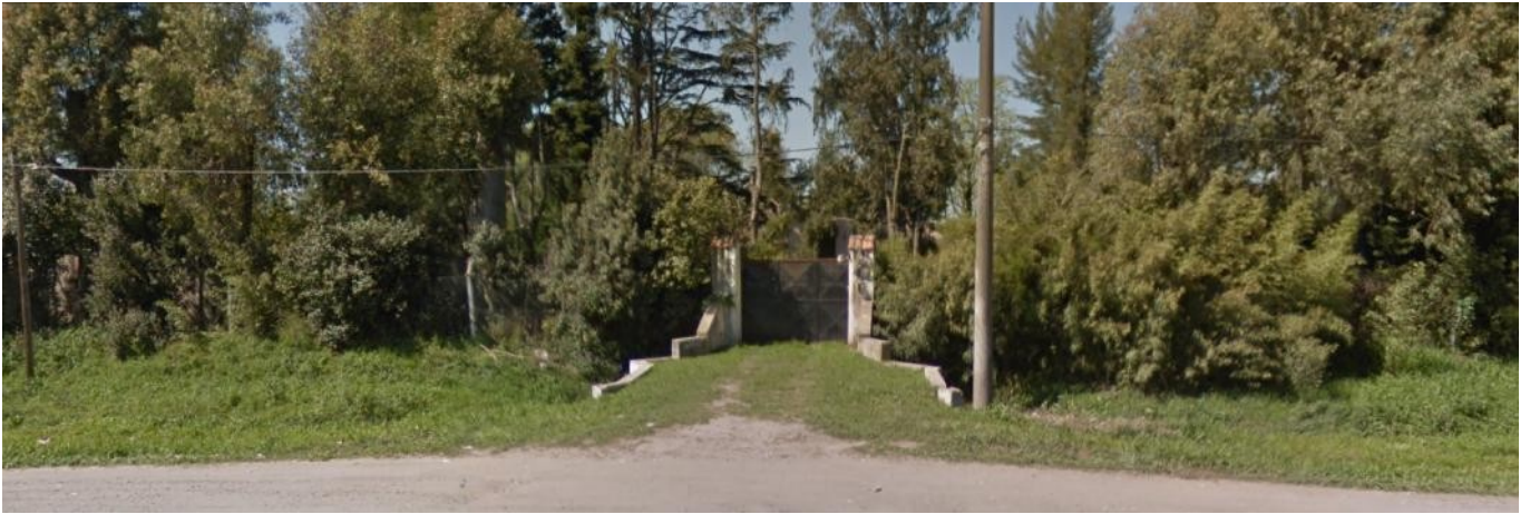
Imagen 14: Acceso Lateral con Alcantarillado - Margen Descendente
