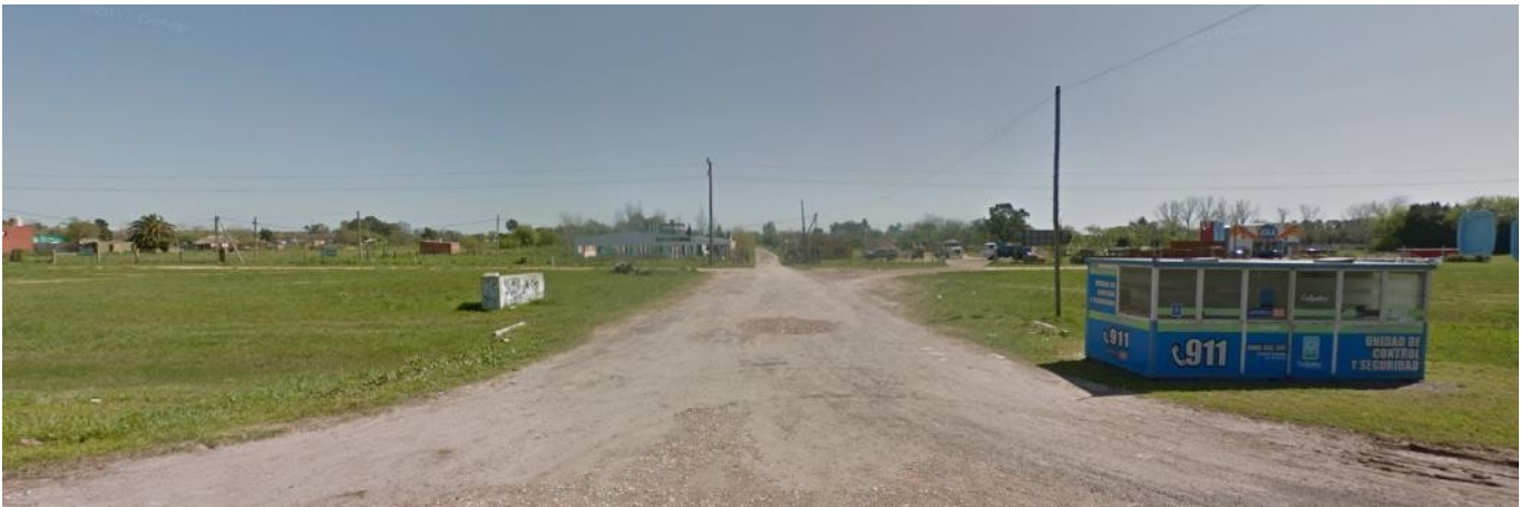
Imagen 17: Acceso Lateral con Alcantarillado - Margen Ascendente
