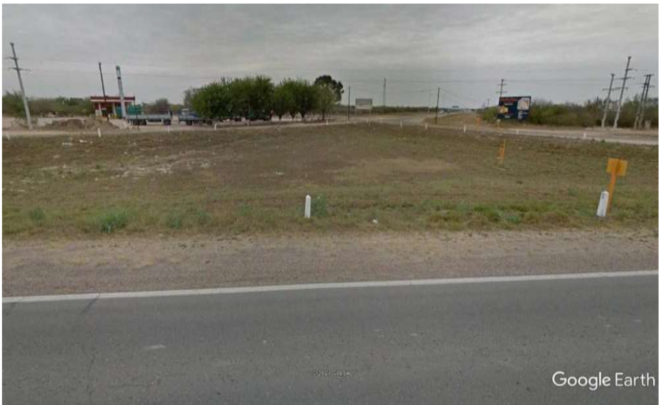
Imagen 6: Cruce de Línea Eléctrica de Media Tensión (Sobre Ramal Acceso Aeropuerto)
