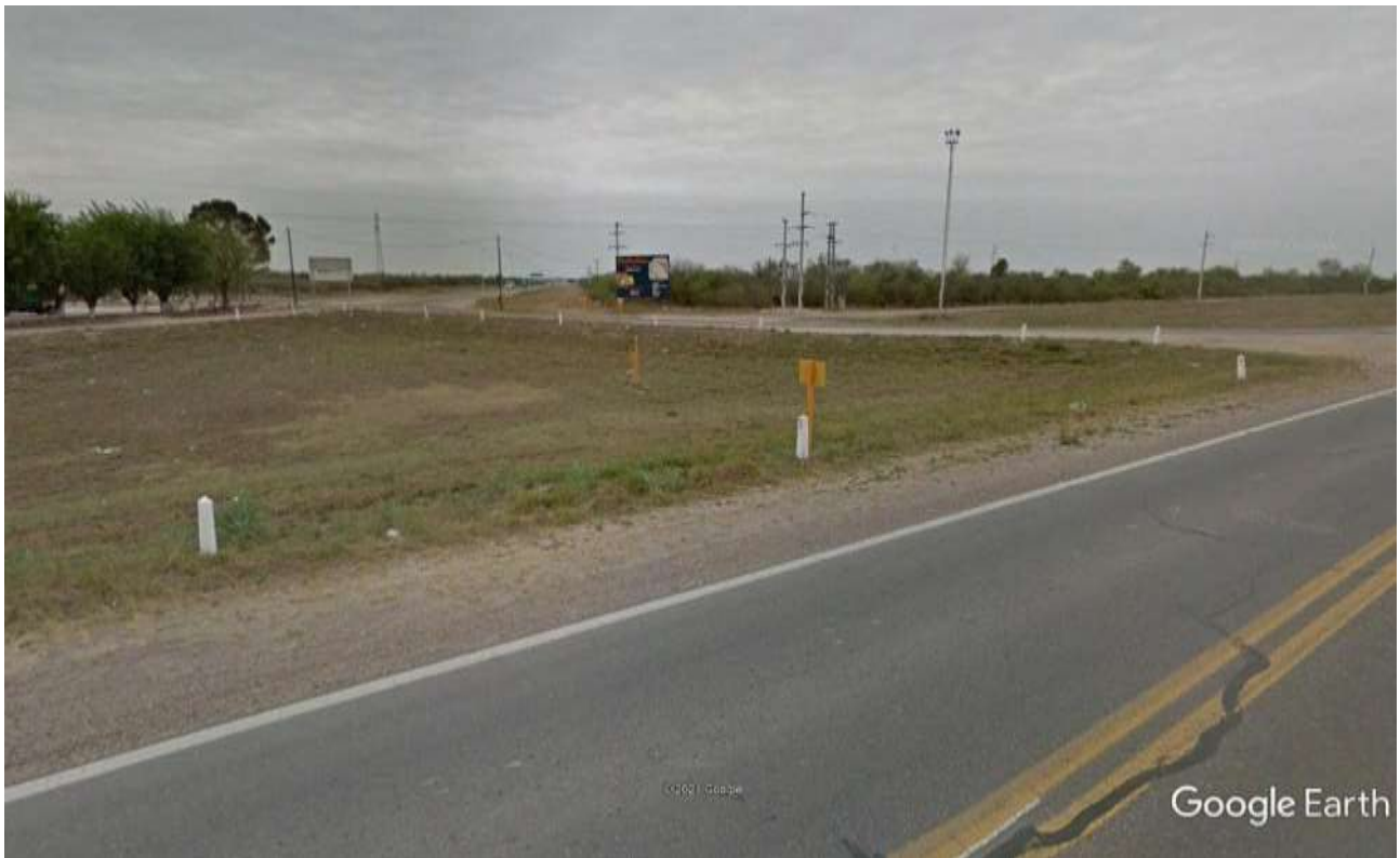
Imagen 7: Cruce de Línea Subterránea de Gas sobre isleta central y rama NE
