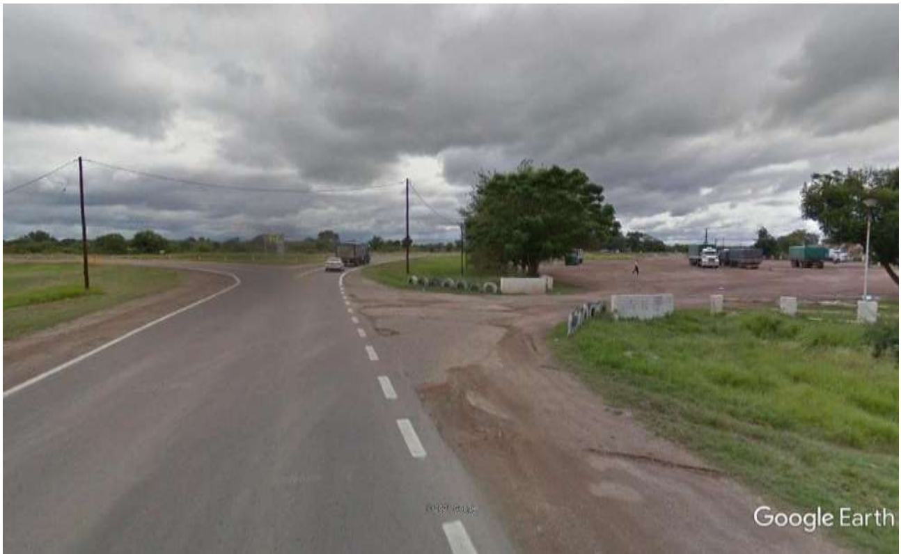
Imagen 13: Acceso N a Intersección (Acceso Aeropuerto)
