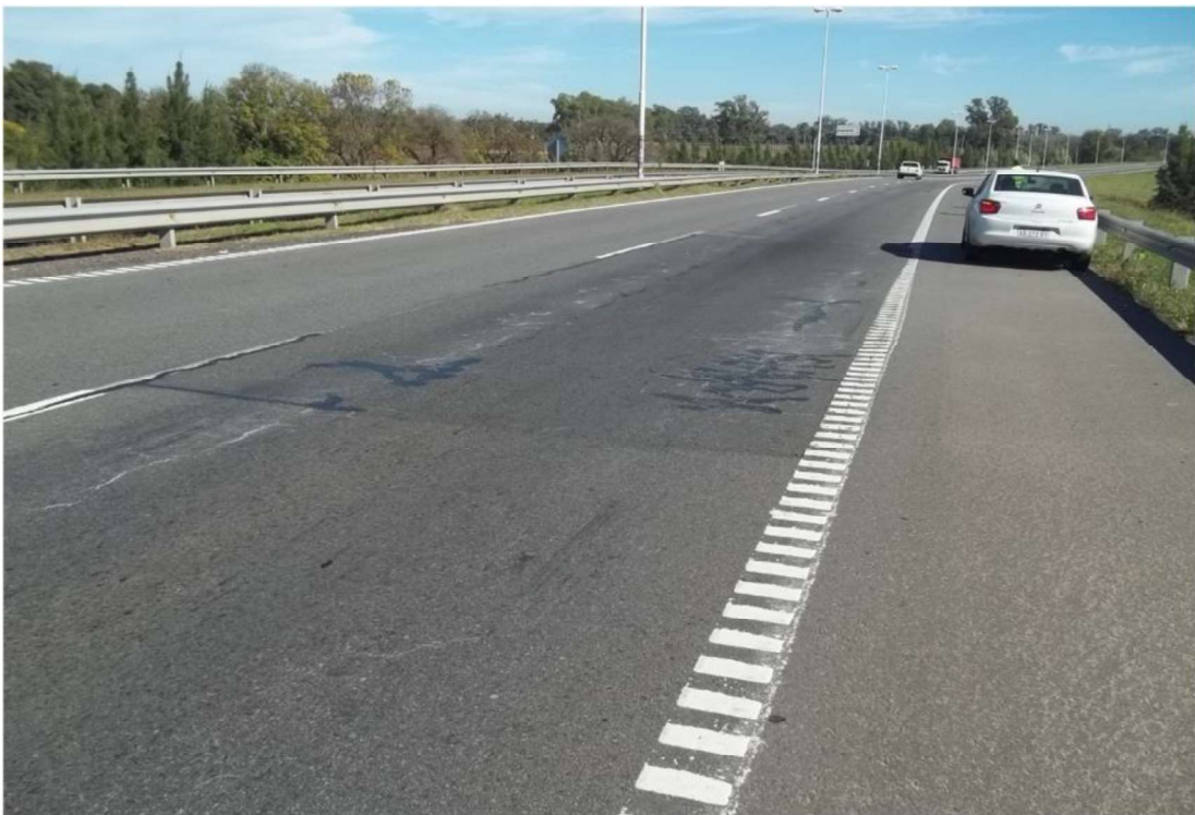
Km. 73,000 - FISURAS RAMIFICADAS AFECTANDO AMBAS HUELLAS. BACHEOS ASFÁLTICOS EN EL ANCHO DEL CARRIL, OBSERVAN FISURAS NUEVAMENTE. SE INTENSIFICAN FISURAS EN CARRIL EXTERNO, LUEGO DEL ALTO NIVEL Y HASTA Km. 74. INICIO DE BANQUINA EXTERNA PAVIMENTADA EN 2,50 M. DE ANCHO.
