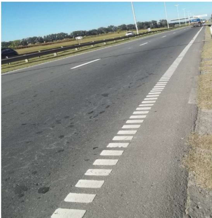
Km. 63,800 - AMBAS HUELLAS DEL CARRIL EXTERNO CON FISURAS RAMIFICADAS TIPO 6, CON CONTINUIDAD A LO LARGO DE LAS HUELLAS. CARRIL INTERNO, CON ESCASOS DETERIOROS EN SUPERFICIE.
