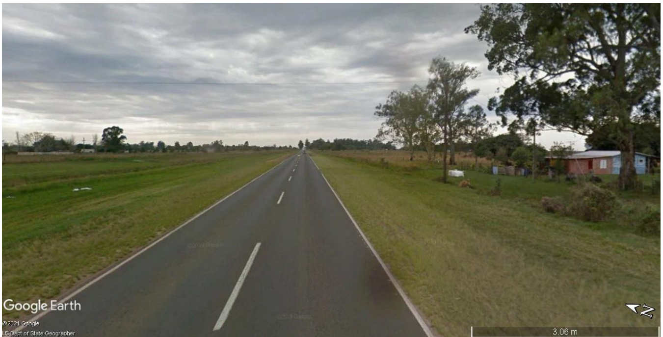
Imagen 3.5 – Vista de Banquinas RN N°12 Km 1254,00 hacia el Noreste
