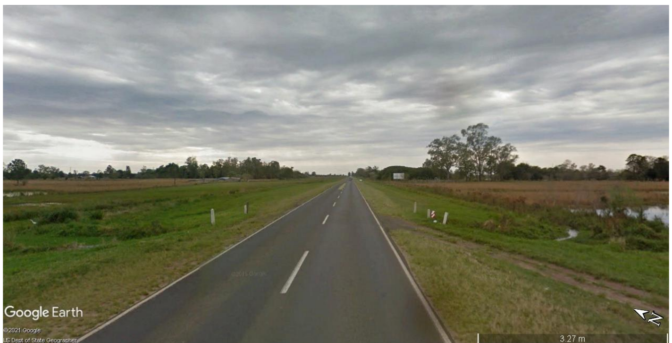
Imagen 3.4 – Vista de Banquinas RN N°12 Km 1253,00 hacia el Noreste
