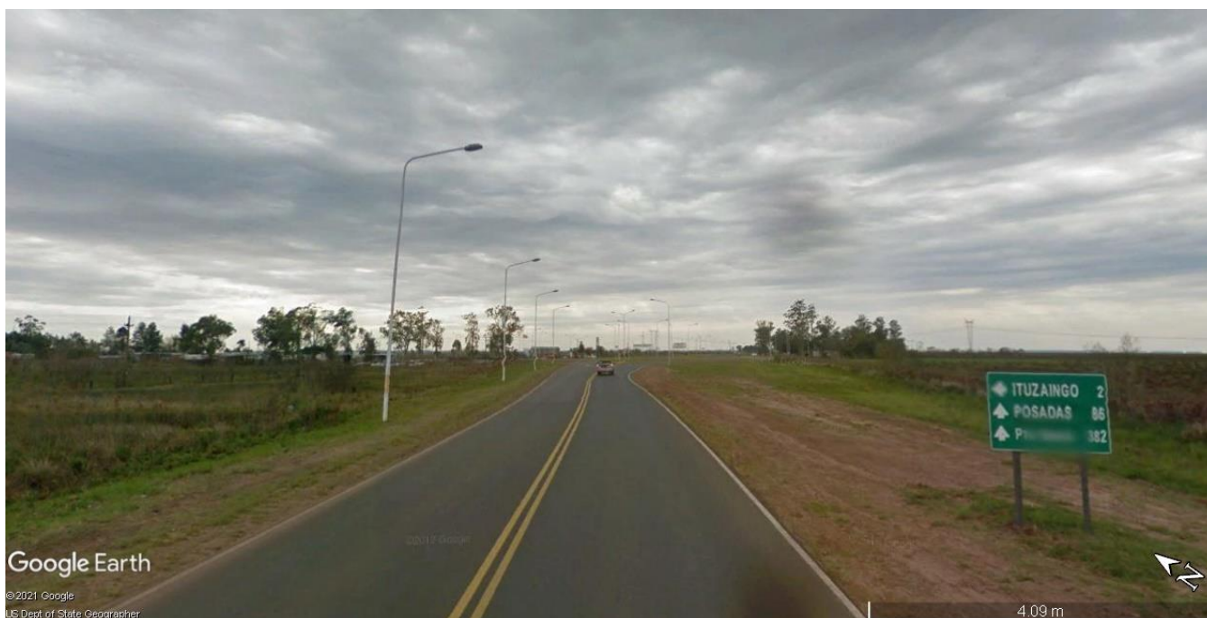
Imagen 3.7 – Vista de Banquinas RN N°12 Km 1256,00 hacia el Noreste
