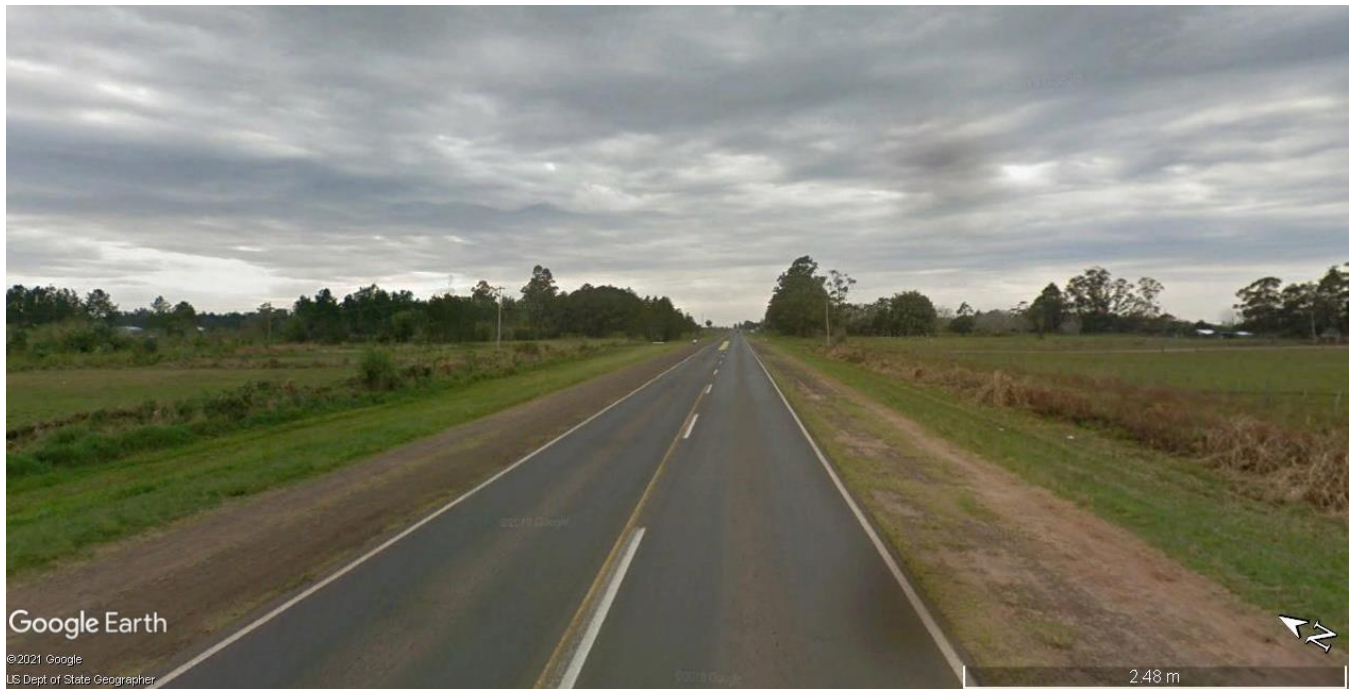
Imagen 3.3 – Vista de Banquinas RN N°12 Km 1252,00 hacia el Noreste
