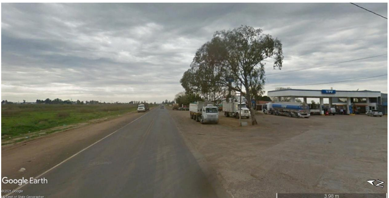
Imagen 3.6 – Vista de Banquinas RN N°12 Km 1255,00 hacia el Noreste
