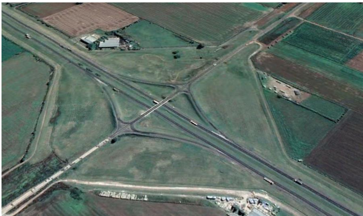
Imagen 2: Distribuidor Villa Constitución
