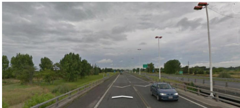
Puente sobre Arroyo Cañuelas
