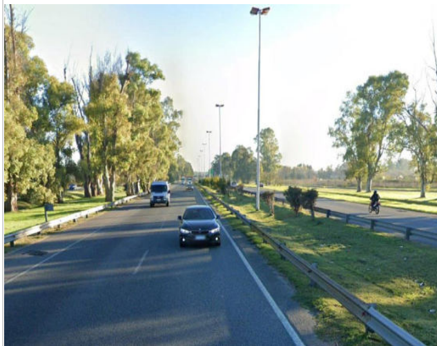
(a) Calzada sentido ascendente
