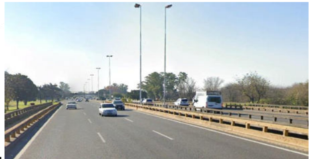
(c) Puente sobre rectificación Río La Matanza
