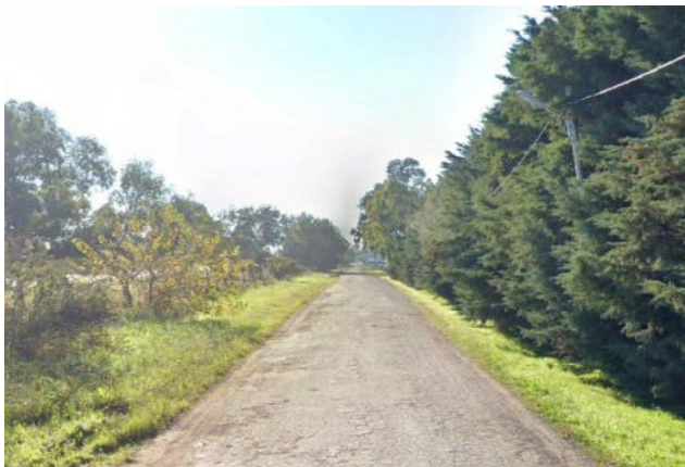
(a) Calzada colectora estabilizada
