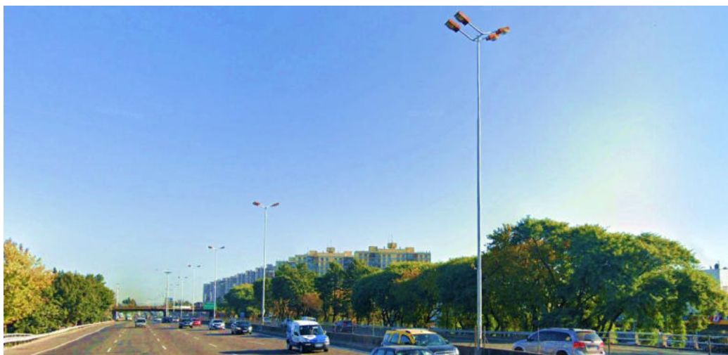
Ilustración 25 – Iluminación de Calzada Principal – Tecnología SAP
