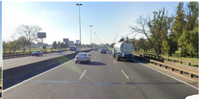
(b) Puente sobre Río La Matanza
