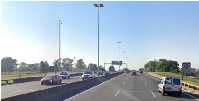
(a) Puente sobre Av. Italia
