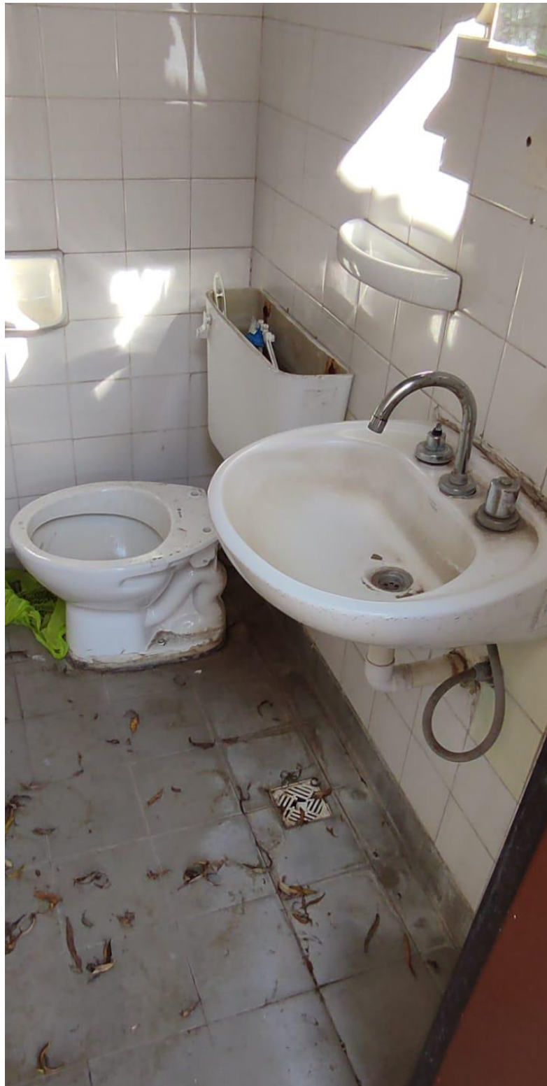
Fotografía 15: Estado actual de los baños (Ambiente 05)
