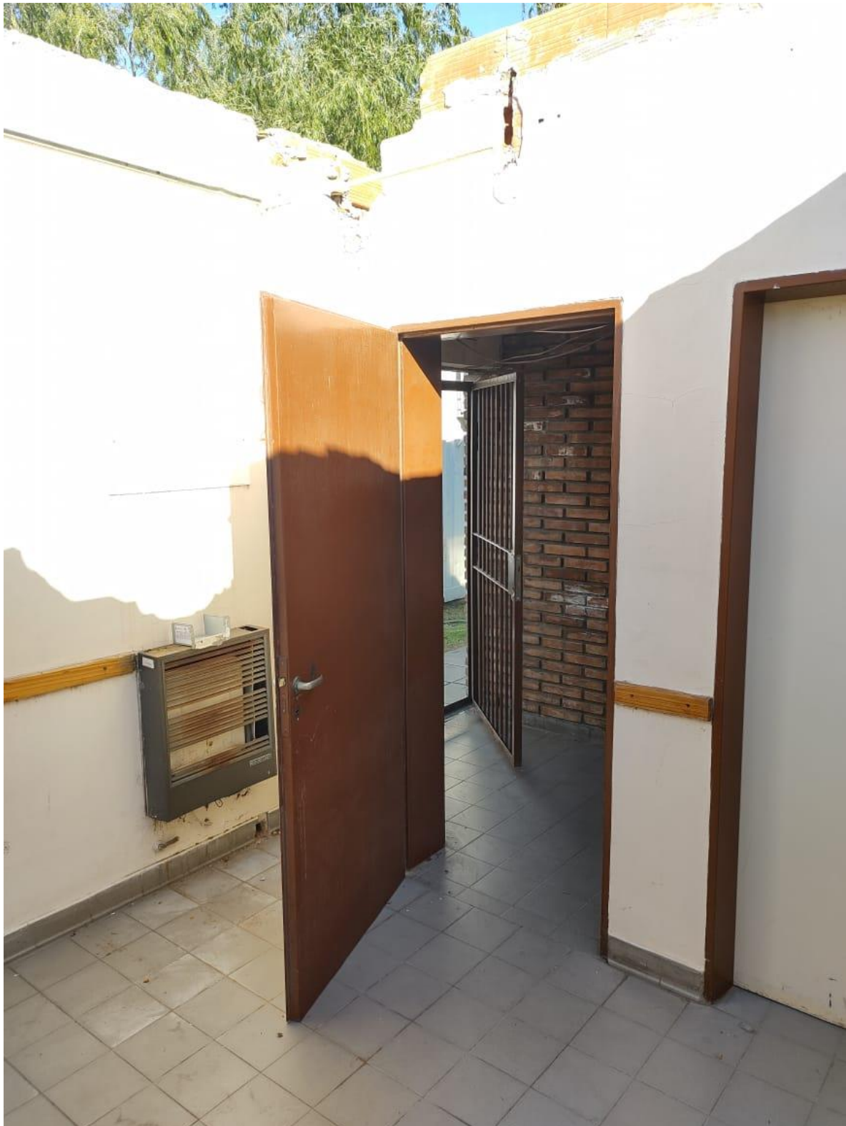
Fotografía 11: Actual salida secundaria o de emergencias. (Ambiente 07)
