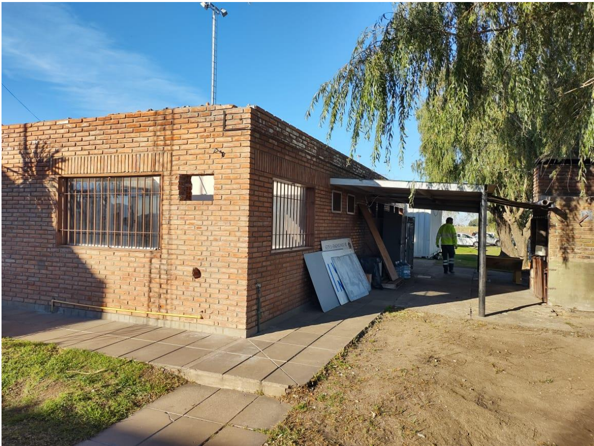
Fotografía 4: Exterior de oficinas administrativas
