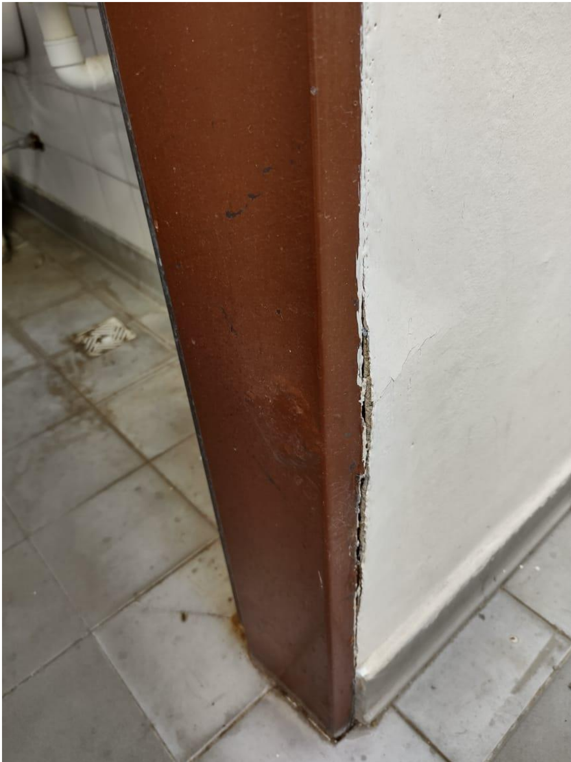
Fotografía 5: Marcos existentes de aberturas internas
