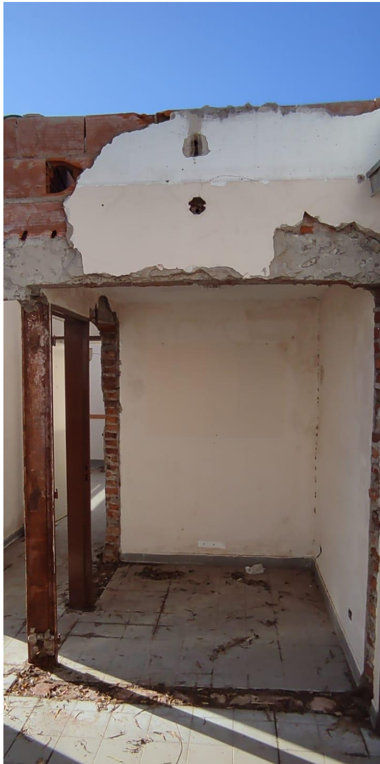
Fotografía 14: Sector de proyección al Paso Distribuidor (Ambiente 03)
