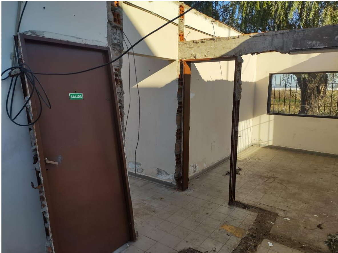
Fotografía 8: Paso distribuidor (Ambiente 03)
