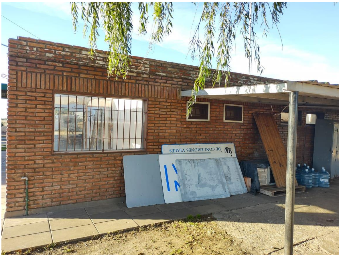
Fotografía 3: Exterior de oficinas administrativas
