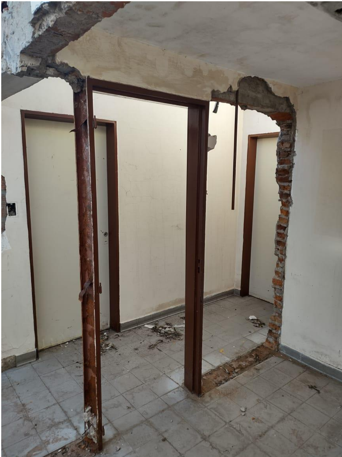
Fotografía 13: Sector de proyección al Paso Distribuidor (Ambiente 03)
