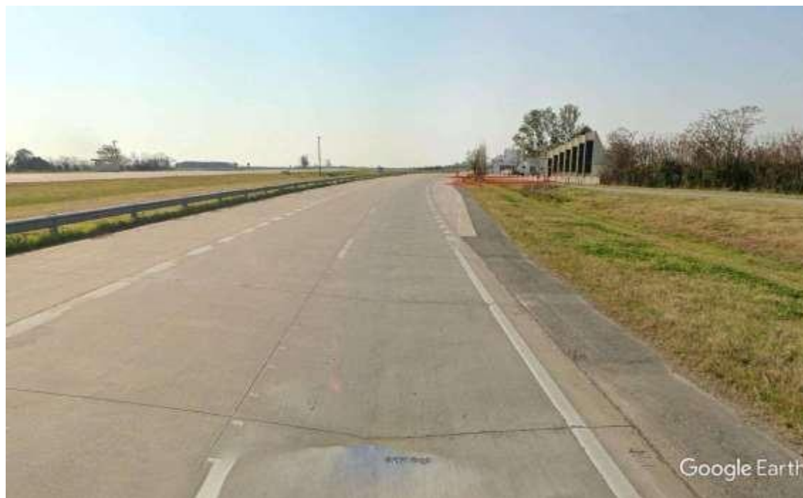
Imagen 3.3 – Calzada Descendente - Inicio de Acceso Vial (Vista Oeste-Este)
