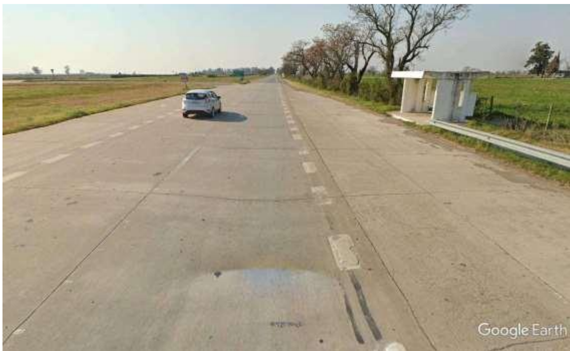
Imagen 3.5 – Calzada Descendente - Parada de Autobús y Refugio (Vista Oeste- Este)
