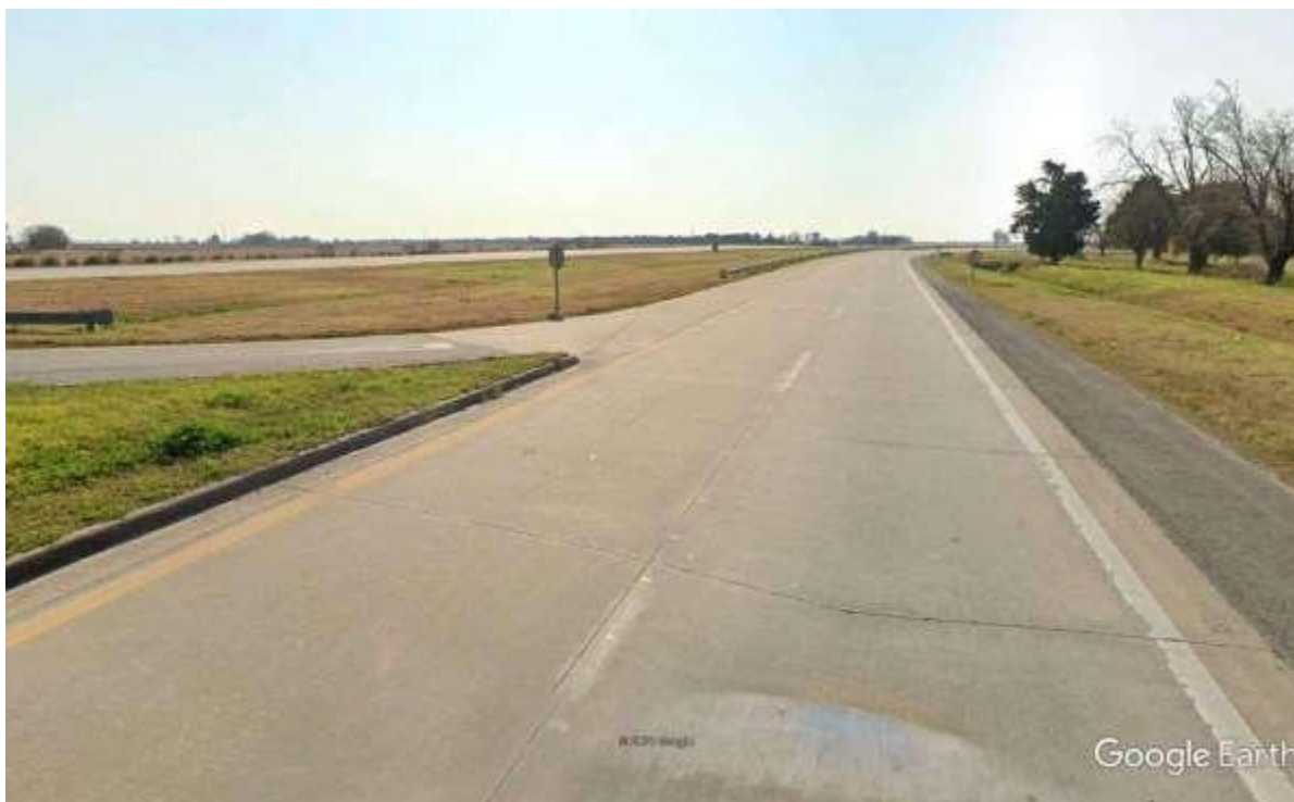
Imagen 3.2 – Calzada Descendente - Inicio de Retorno Vial (Vista Oeste - Este)
