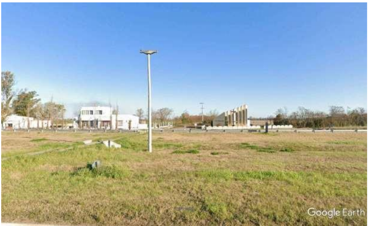
Imagen 3.9 – Cruce de Línea de Media Tensión (Vista Norte - Sur)
