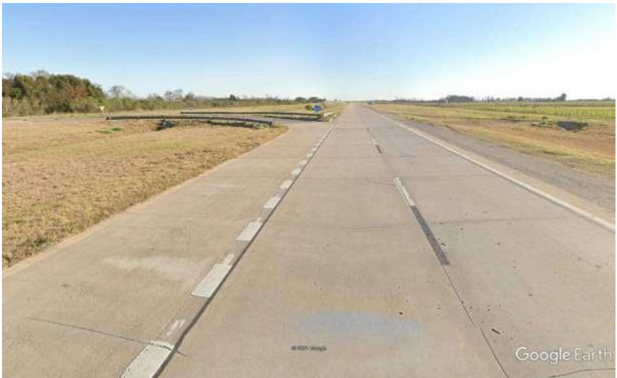
Imagen 3.11 – Calzada Ascendente - Fin de Retorno Vial (Vista Este - Oeste)
