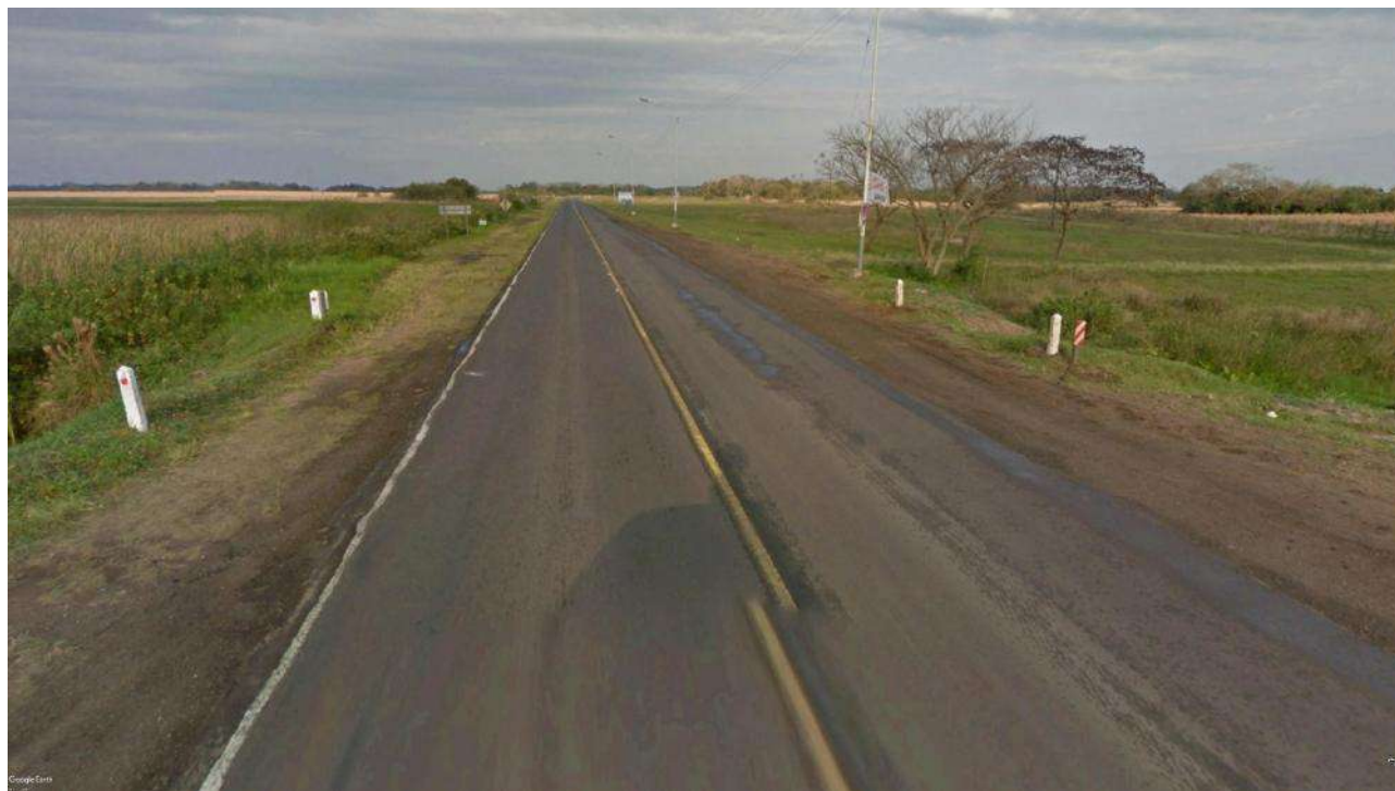
Imagen 10.7: Alcantarilla Transversal O-41211-I - Km 1089.07
