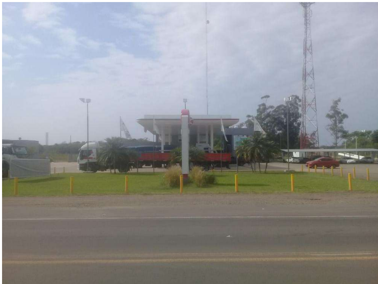
Imagen 10.3: Estación de Servicio AXION PETRO ITATÍ sobre lado Sur
