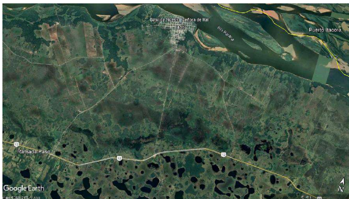
Imagen 2.3 – Imagen Aérea RN N°12 y Acceso a Itatí, Corrientes
