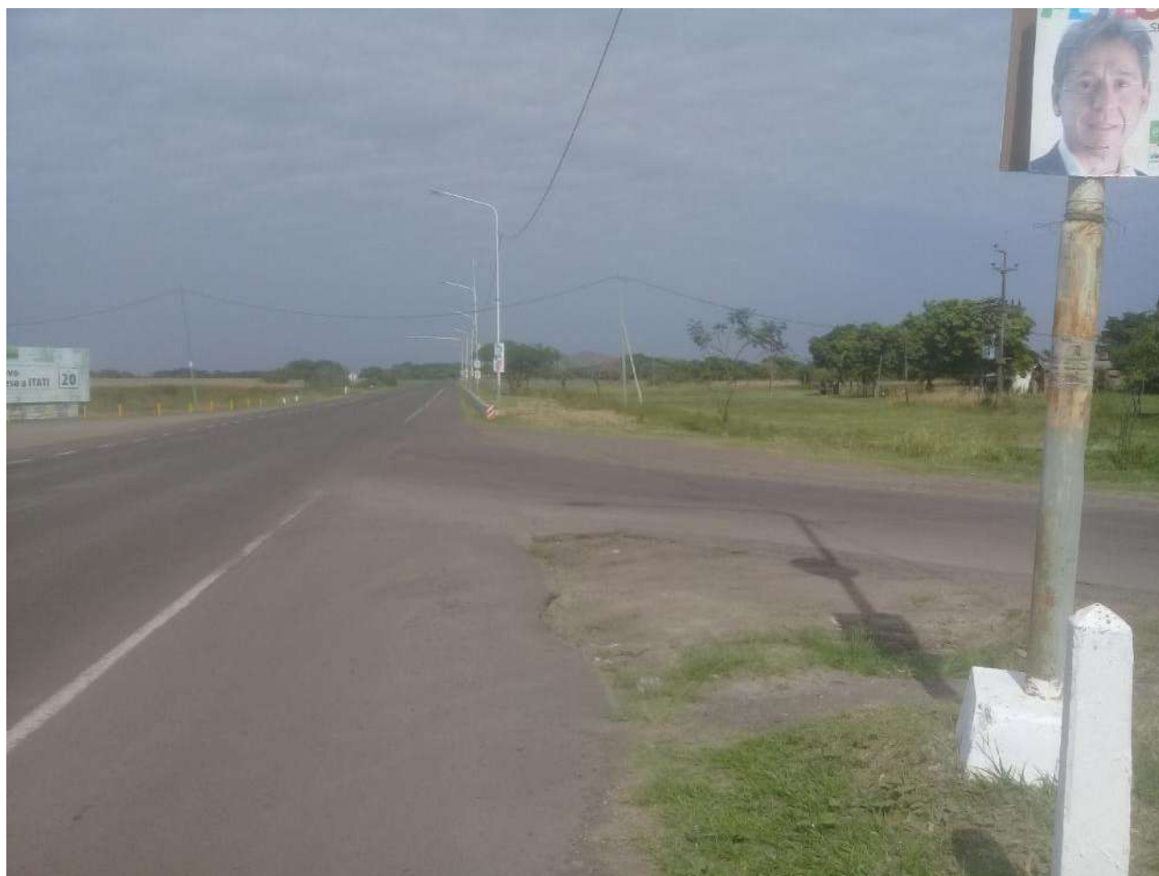
Imagen 10.6: Cruce Aéreo de Línea de Baja Tensión (Dirección Corrientes)
