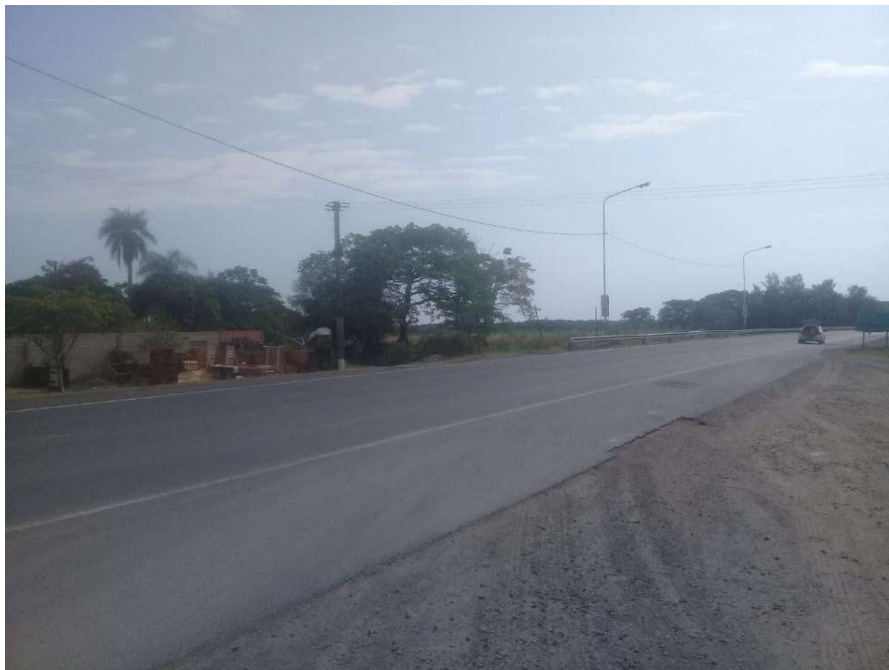
Imagen 10.4: Pavimento RN N°12 Existente
