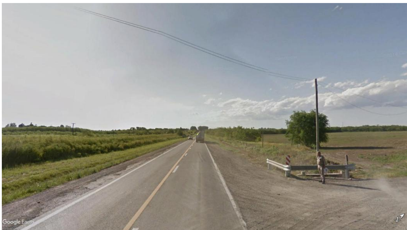
Imagen 3.6 – Vista de ubicación prevista de cruce subterráneo sobre RN N°8 Km 179,56
