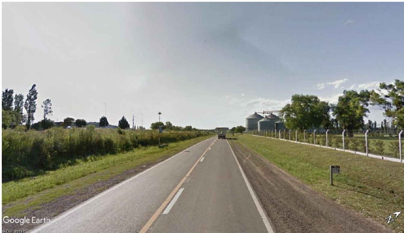
Imagen 3.1 – Vista de RNN°8 Km 179
