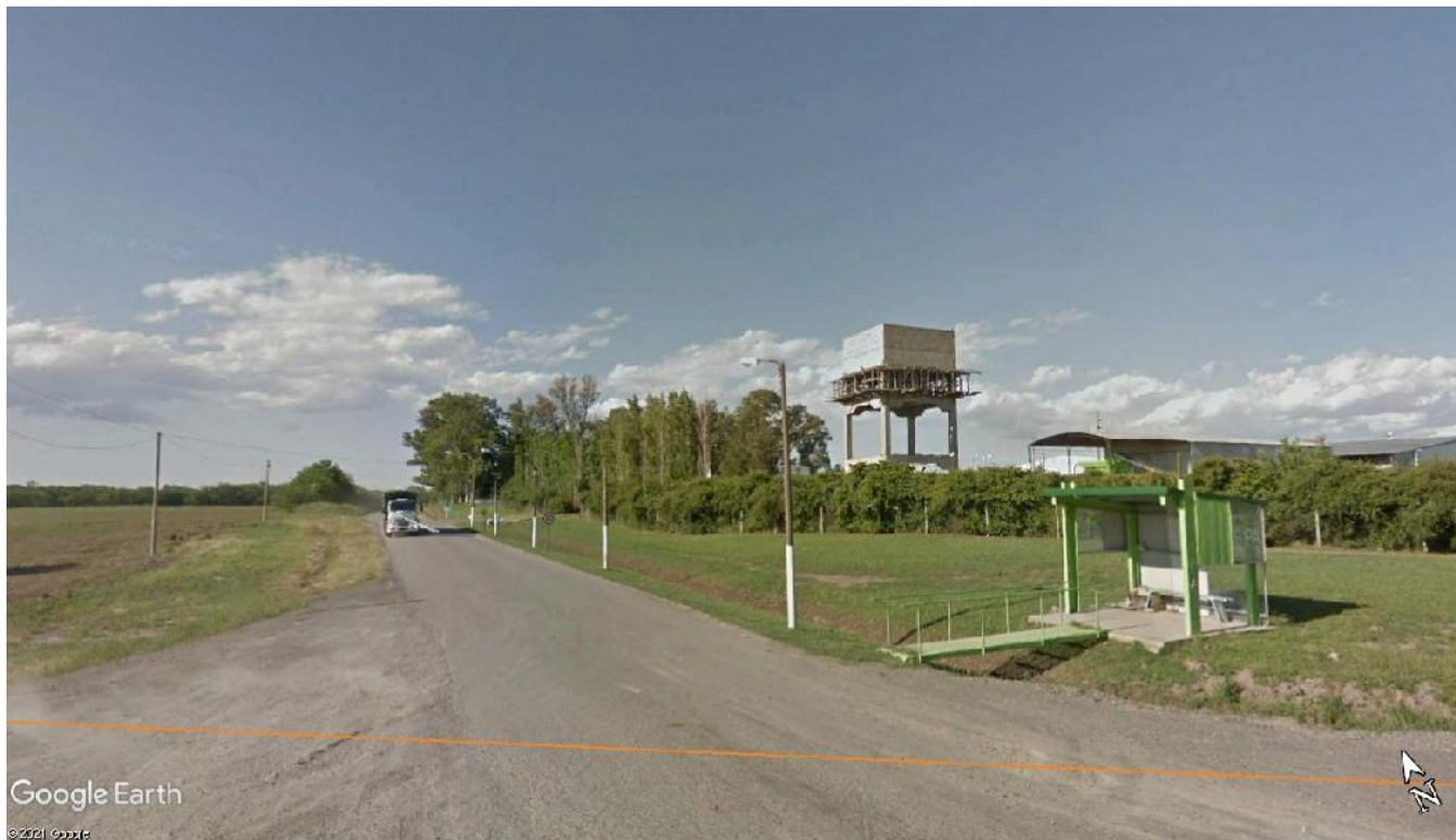
Imagen 3.3 – Vista de Acceso a Parque Industrial Arrecifes – Columnas a Reubicar
