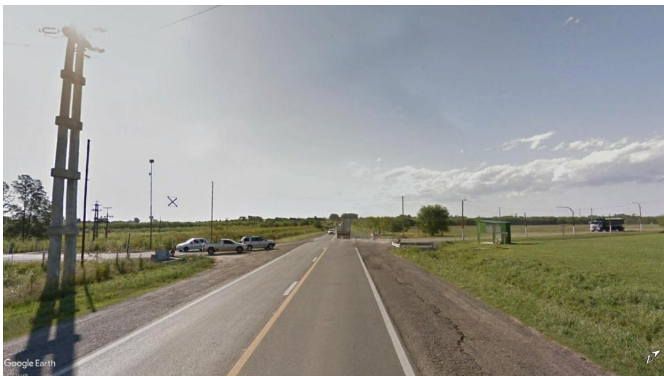
Imagen 3.2 – Vista RN N°8 Km 179,50 y Acceso Parque Industrial Arrecifes (Lado Asc.)
